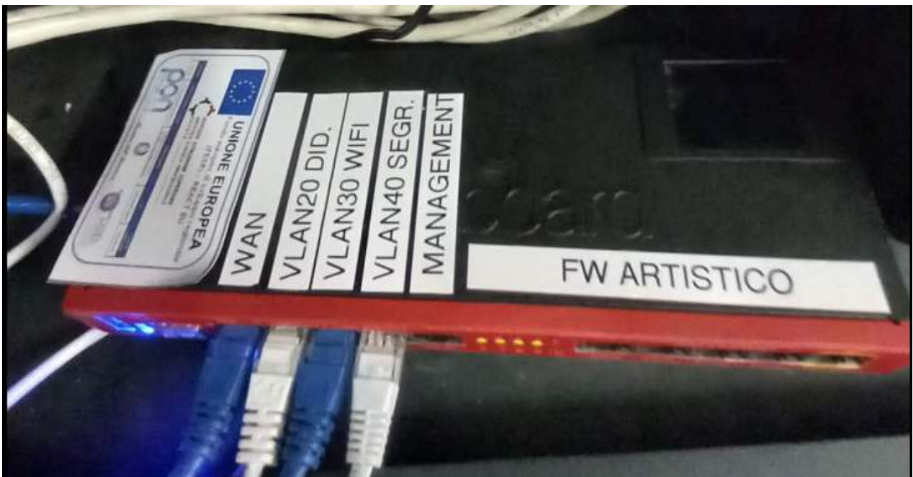
Firewall installati n.3 (uno sede Artistico, uno sede IPSIA e uno sede Classico) permettono la navigazione controllata e sicura sulla rete Internet nelle tre sedi.
